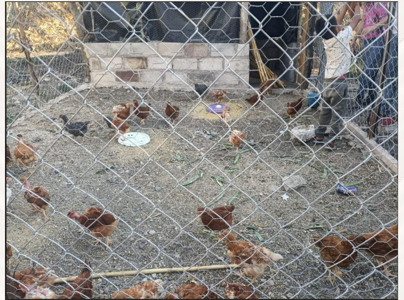
Gallinero que se constuyó
